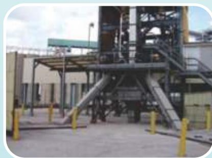
Projeto de multi-produto por atacado para expedição, contendo na torre silo de 50 t e silo balança de pesagem de 15 t.
