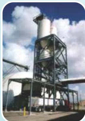
Sistema de carregamento de Uréia de alta velocidade em Channelview, Texas USA. Retomada a partir do topo das torres com silos de 60 t e utilização de Bulk-Toters de 300 TPH.
